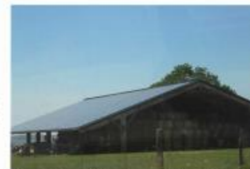
Hangar récent à toiture solaire, secteur de Montredon-Labessonnié
