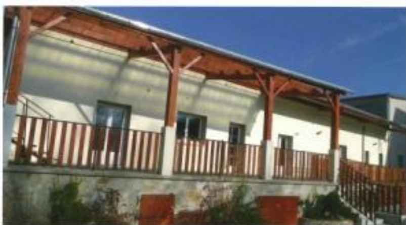
Réhabilitation d'un atelier industriel en logements, Sidobre
