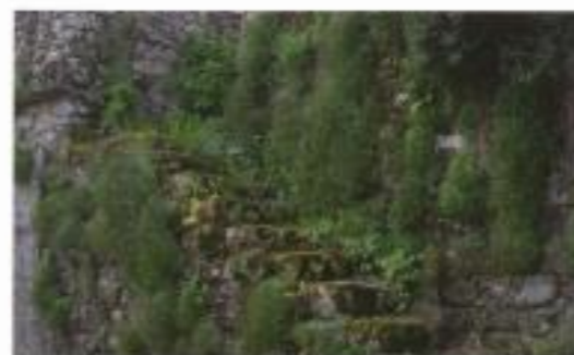
Murs de soutènement et escalier, hameau de Villelongue
